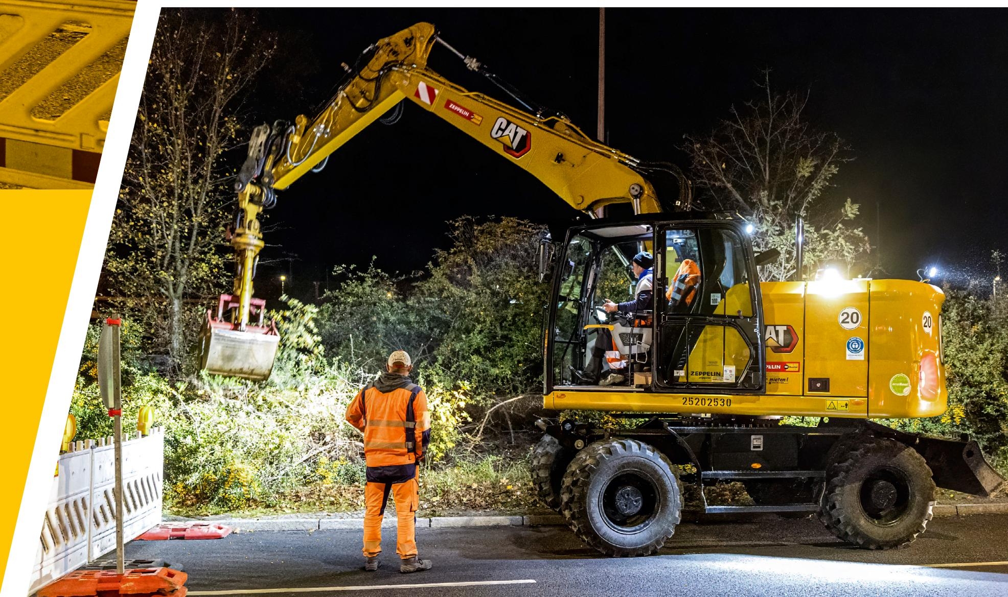
Zusätzlich wurde ein Mobilbagger CAT M314 für Rodungsarbeiten am Mittelstreifen eingesetzt, die als vorbereitende Maßnahme für den anschließenden Neubau der Brücke erforderlich waren
