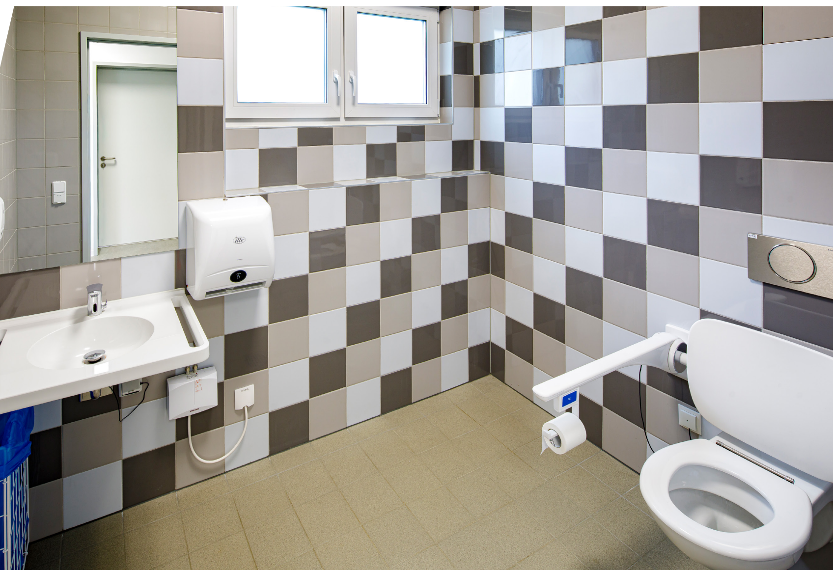
Das barrierefreie WC wurde mit robusten Fliesen in marmorierter Graustruktur realisiert
