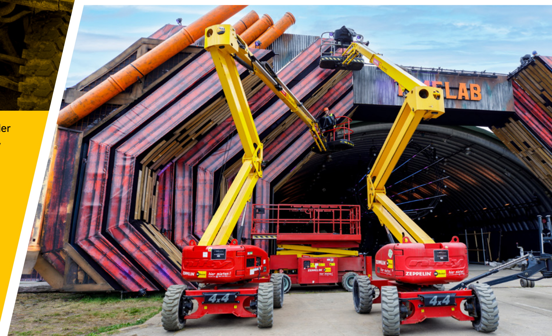
Paralleler Einsatz zahlreicher Arbeitsbühnen: Insgesamt unterstützten 40 Gelenkteleskopbühnen und 25 Scherenarbeitsbühnen den Bühnenbau
